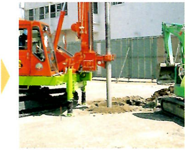
2 注入混合攪拌状況
